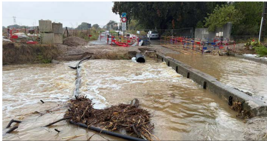
L'ancien pont de la Route de Valergues : un obstacle bientôt démoli pour faciliter l'écoulement des eaux en cas de crue.
